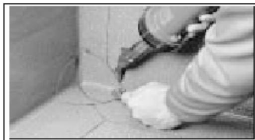
Не сваривайте непосредственно на готовой мембранный поверхности. Найдите древесину, чтобы подложить под свариваемую деталь.
