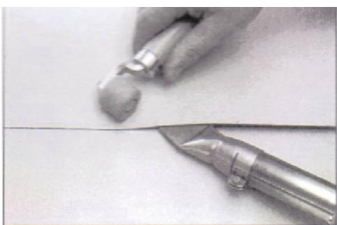
рулон, с нахлестом равным 130мм для рулона шириной 1м., и 140мм для рулона шириной 2м. Закрепить один торец, натянуть, закрепить другой;
