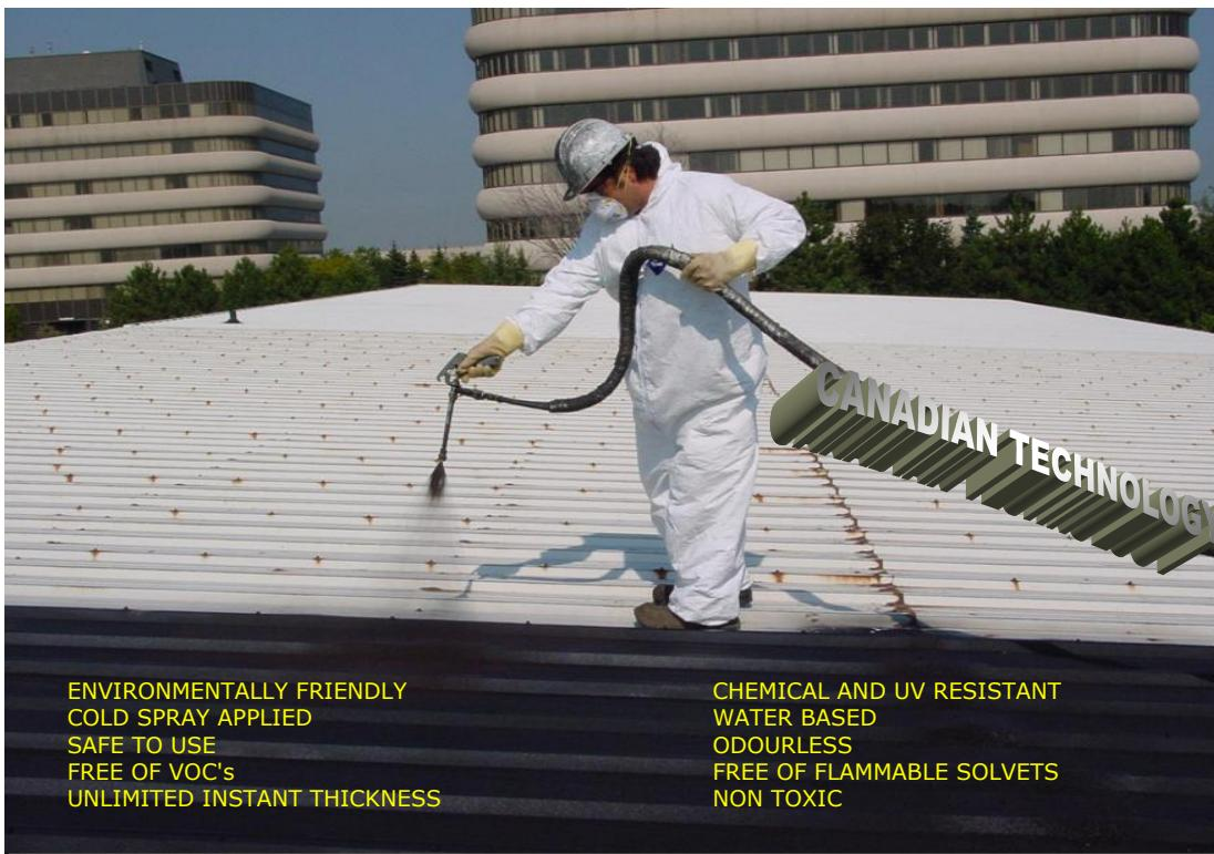
Универсальная мембранный система покрытий на основе жидкой резины - это достижение в гидроизоляции и защите от коррозии. Данная система холодного нанесения - распылением и однокомпонентное покрытие были разработаны для решения проблем возникающих при использовании обычных мембранных систем.
